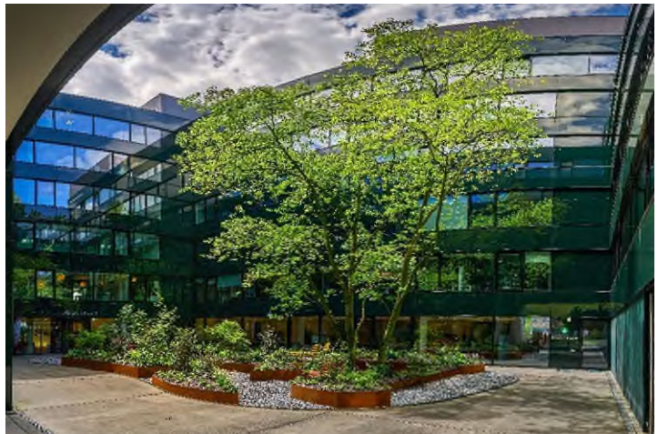
Abb. 25: Neu gestalteter Innenhof Z5
